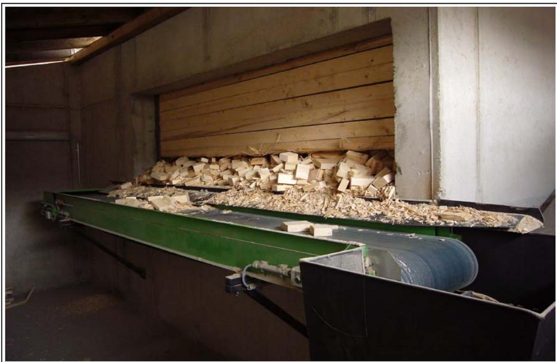
Abbildung 4: Brennstofflager der HVG-Anlage
