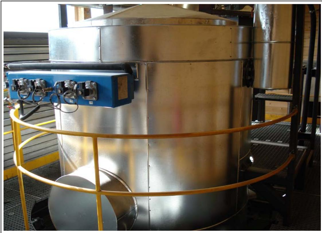
Abbildung 6: Heißgasfilter der HVG-Anlage
