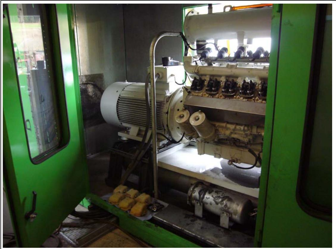
Abbildung 7: Gasverbrennungskraftmaschine der HVG-Anlage
