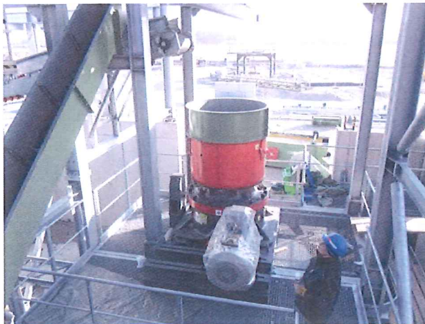
Bild 2: Der Kegelbrecher wird eingebaut
