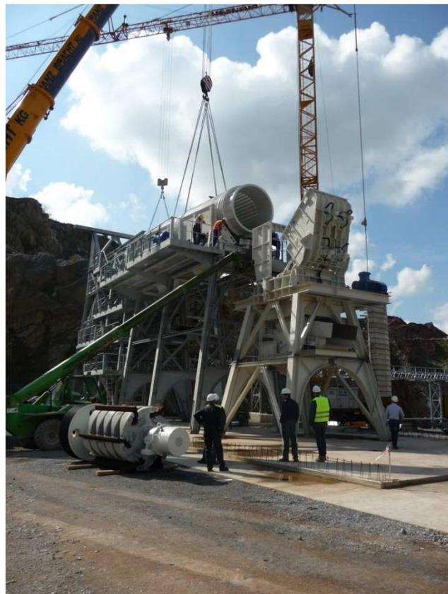
Abbildung 13: Montage der Siebtrommel und des Rotors am 16.09.2014
