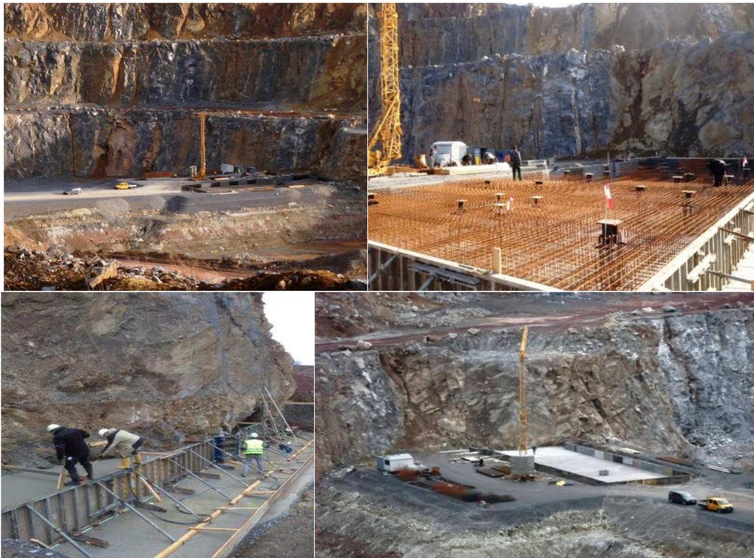
Abbildung 8: Fundamentarbeiten für den Standort Vorbruchanlage mit Siebtrommel Februar/März 2014
