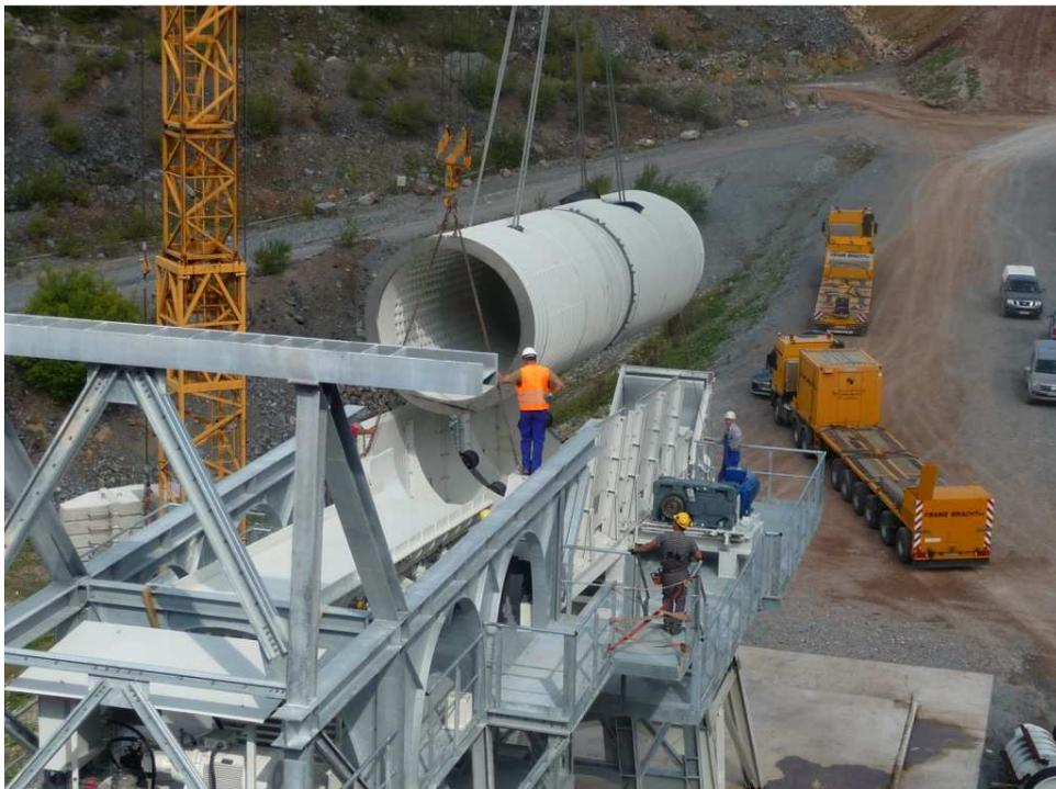
Abbildung 11: Montage der Siebtrommel am 16.09.2014
