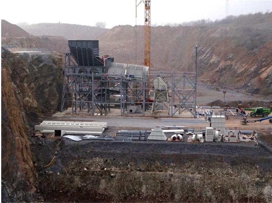
Abbildung 16: Bauteile Anfahrtsbrücke und Entstaubungsanlage vor der Anlage 25.03.2015
