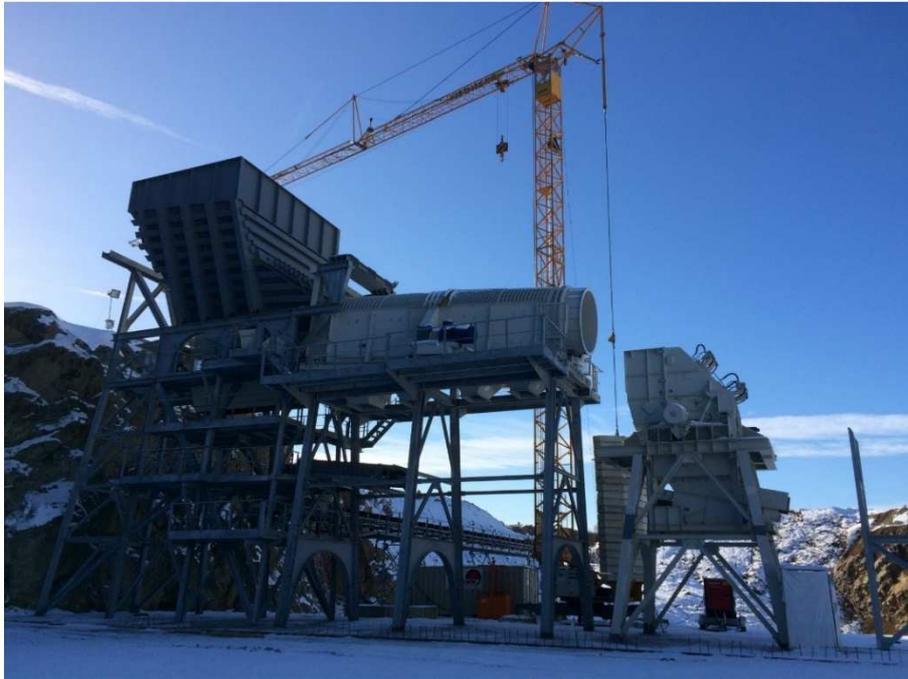
Abbildung 14: Zustandsfoto Baustand Vorbrucharanlage mit Siebtrommel am 08.02.2015
