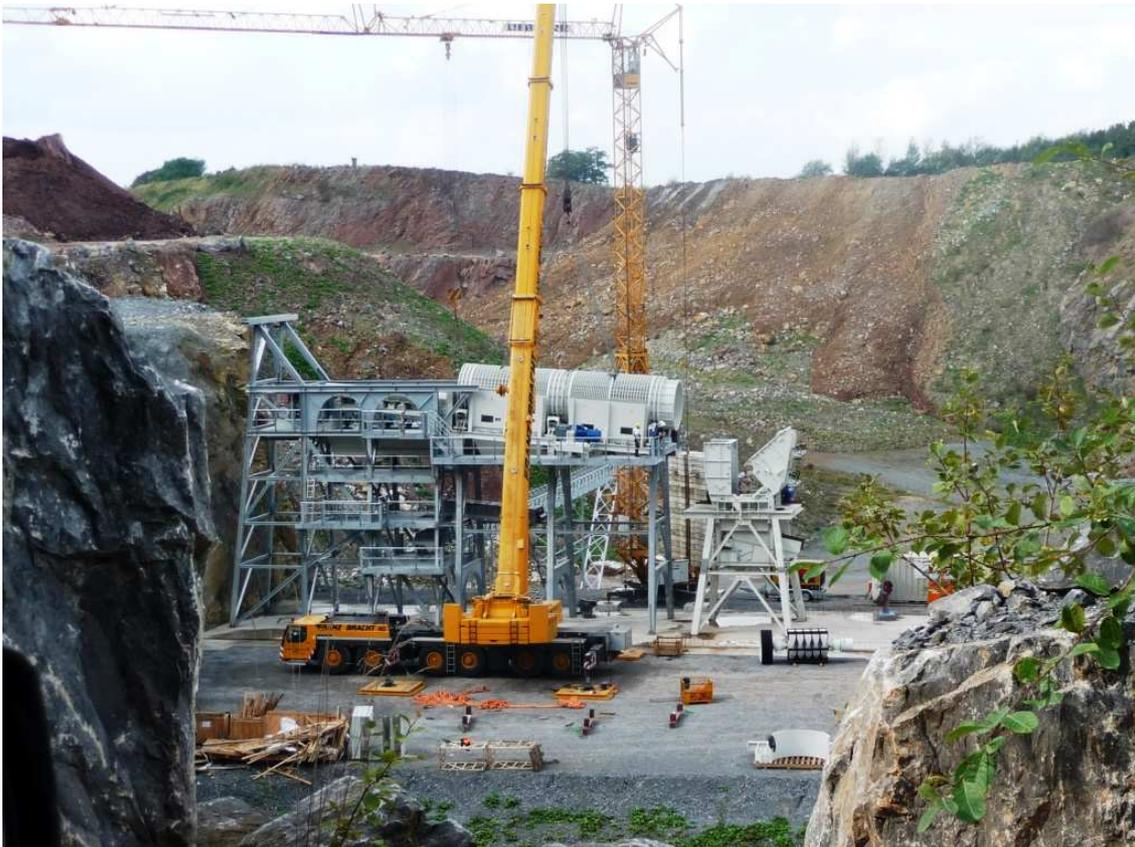
Abbildung 12: Montage der Siebtrommel am 16.09.2014
