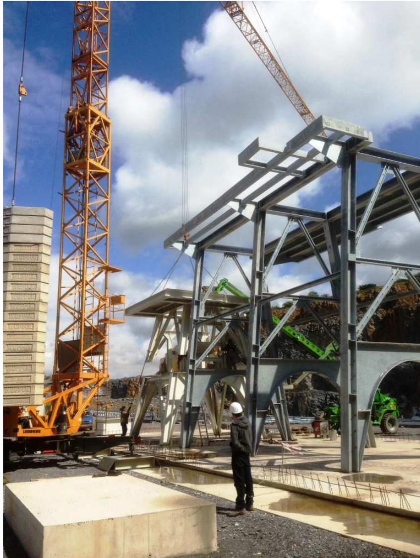
Abbildung 9: Stahlbaukonstruktion Siebtrommel 14.08.2014
