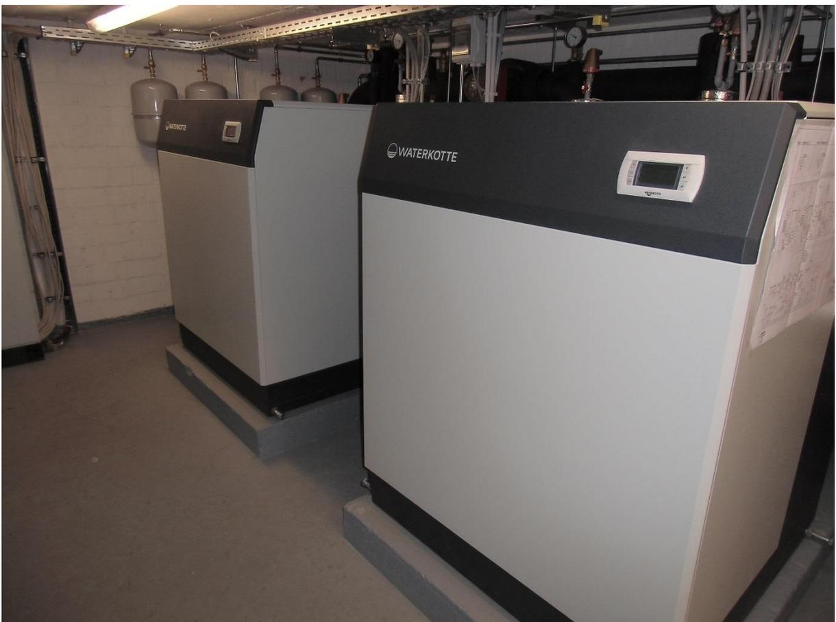
Abbildung 7: Abwasserwärmepumpen in der Heizzentrale
