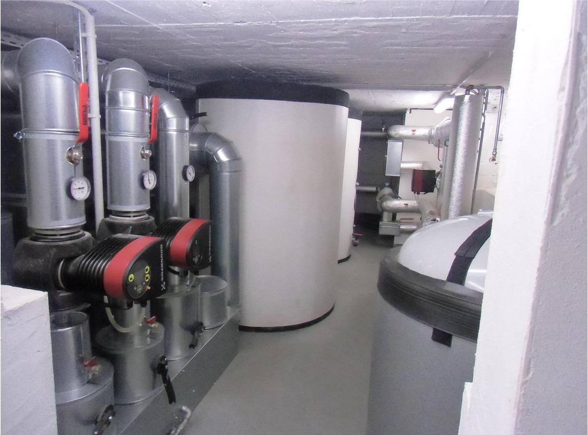
Abbildung 8: Heizungswasserspeicher in der Heizzentrale
