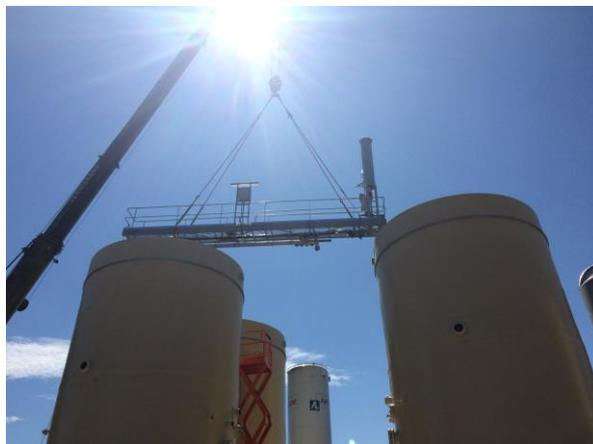
Abbildung 17: Montage Gasfackel und Laufsteg (21.07.2015)
