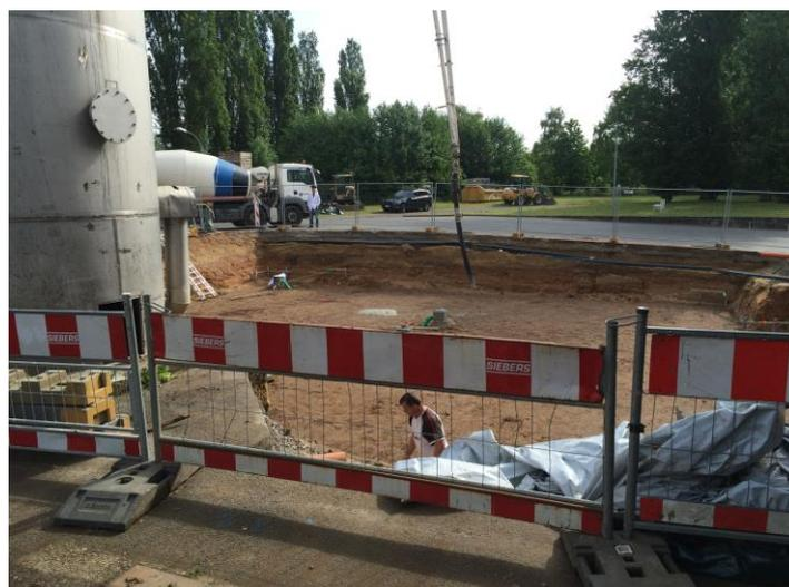
Abbildung 10: Grube mit Betonsauberkeitsschicht (01.06.2015)
