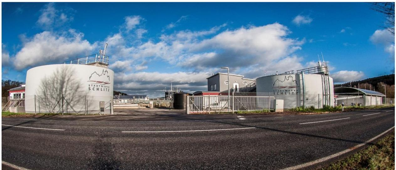
Abb. 2-9: Annahme- und Lagerbehälter für externe Klärschlämme (links), (Foto Stadtwerke Schlitz)
