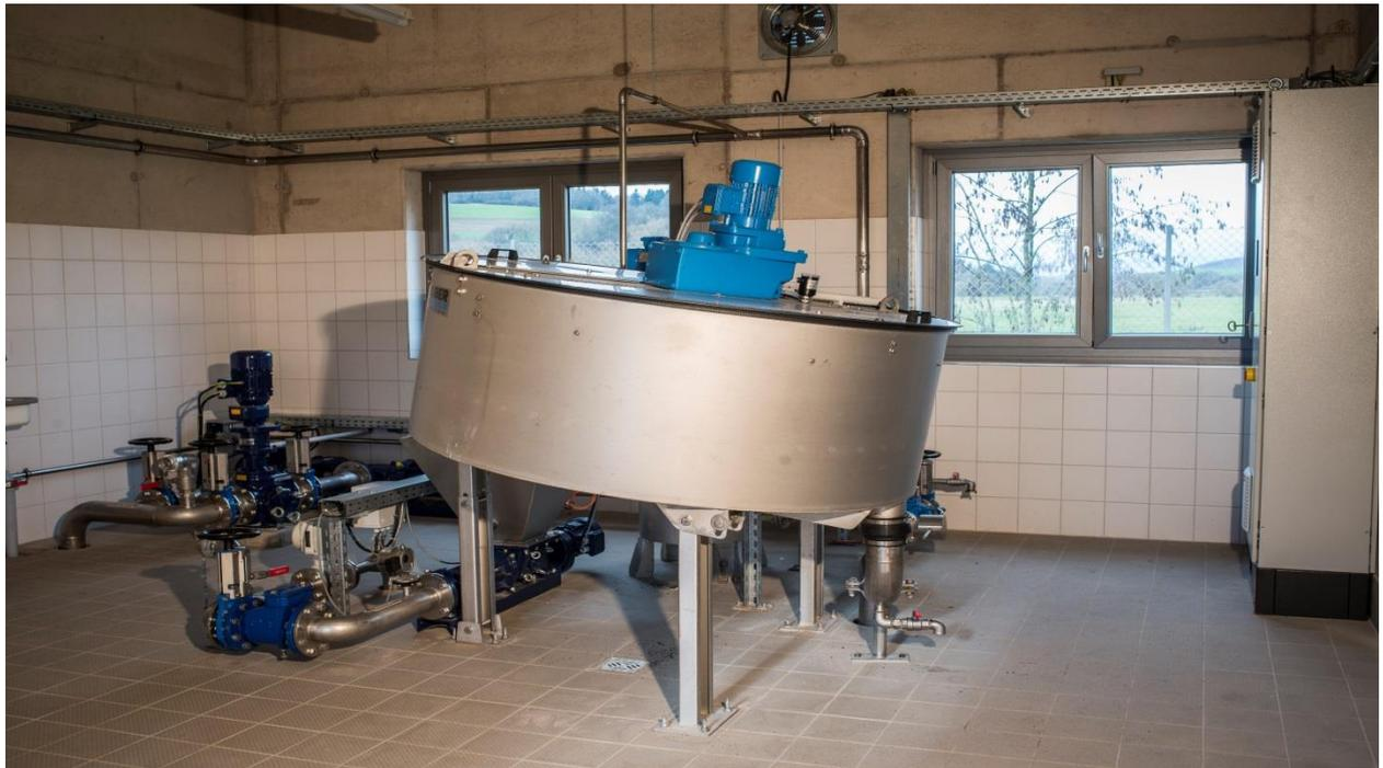
Abb. 2-10: Maschinelle Überschussschlammverdickung (Huber ROTAMAT® Scheibeneindicker RoS 2S), (Foto Stadtwerke Schlitz)
