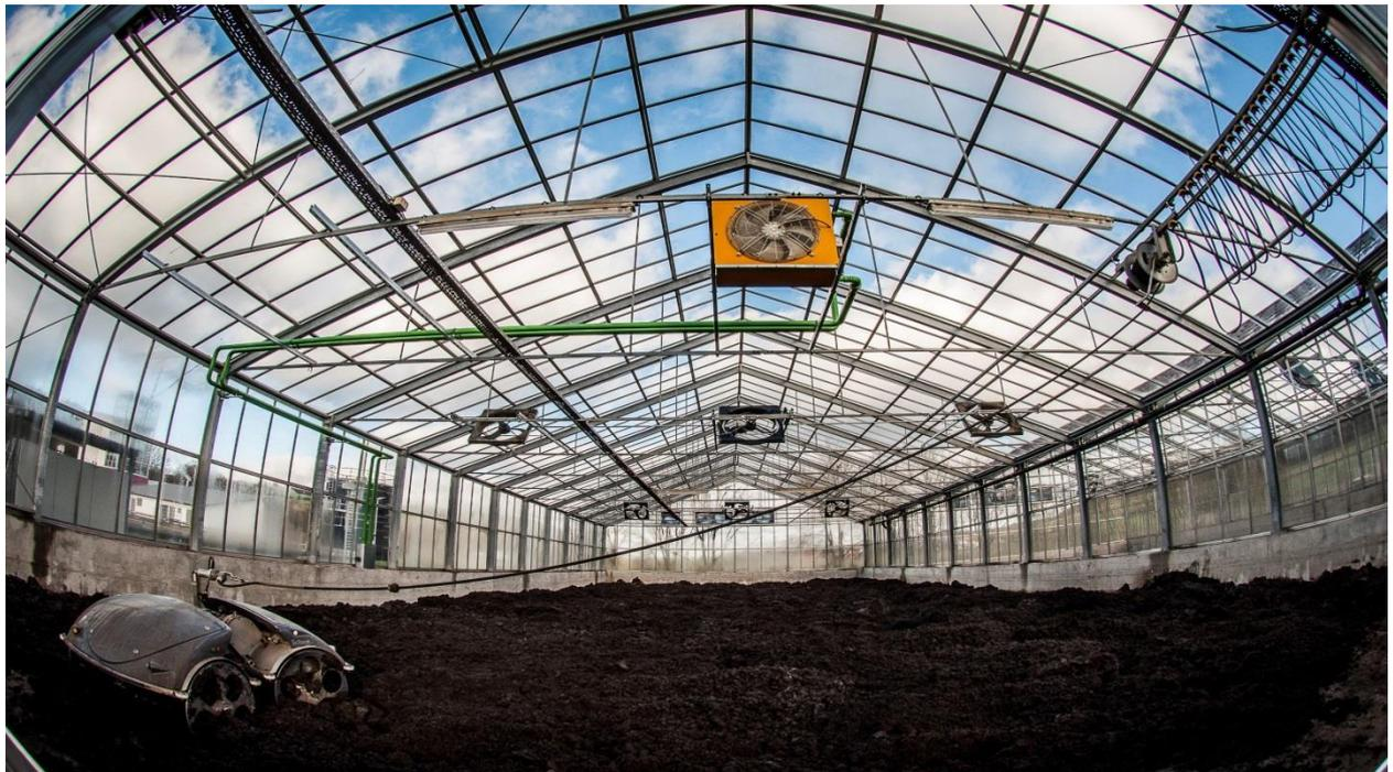
Abb. 2-13: Wärmetauscher zur Einbringung von Abwärme aus dem BHKW zur Optimierung der solaren Klärschlamm-trocknung, (Foto Stadtwerke Schlitz)
