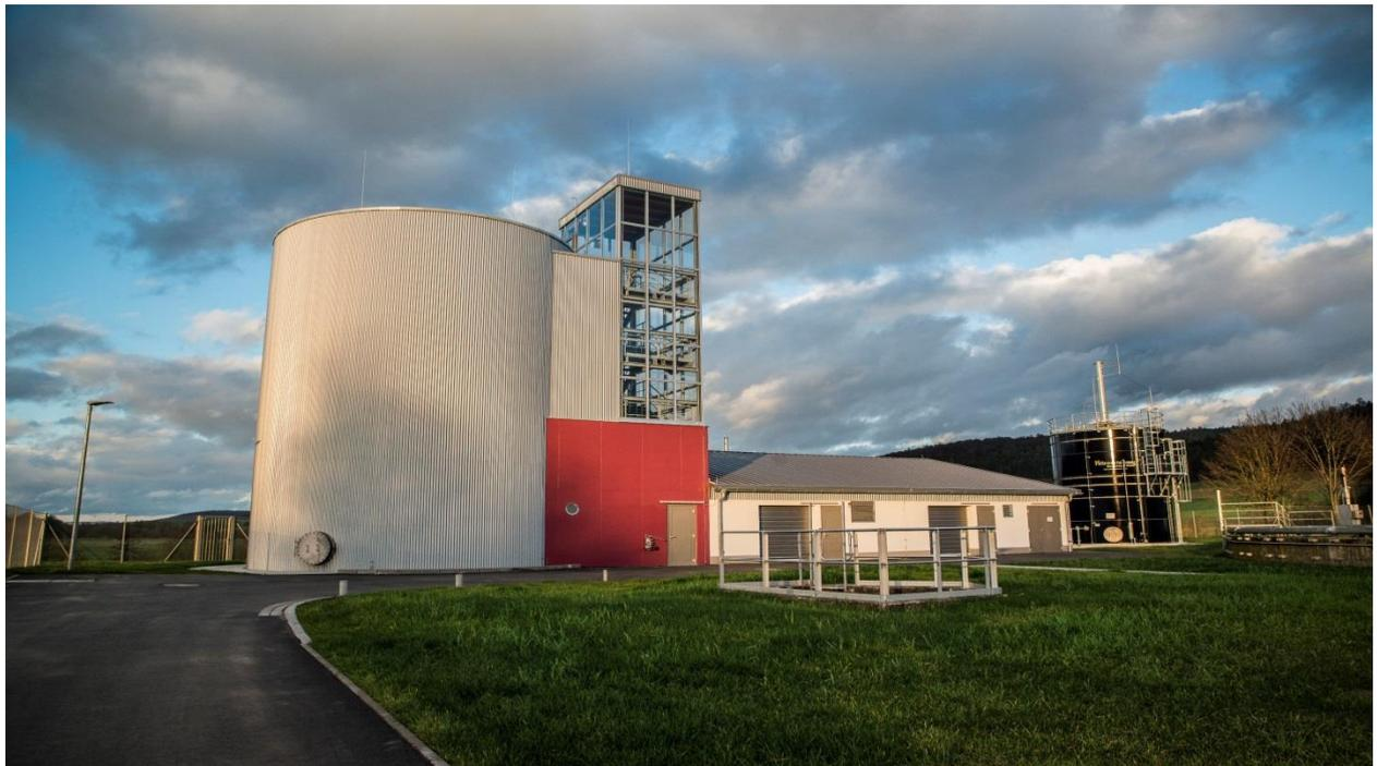
Abb. 2-11: Faulbehälter mit Betriebsgebäude Schlammbehandlung und Faulgasverwertung (Foto Stadtwerke Schlitz)
