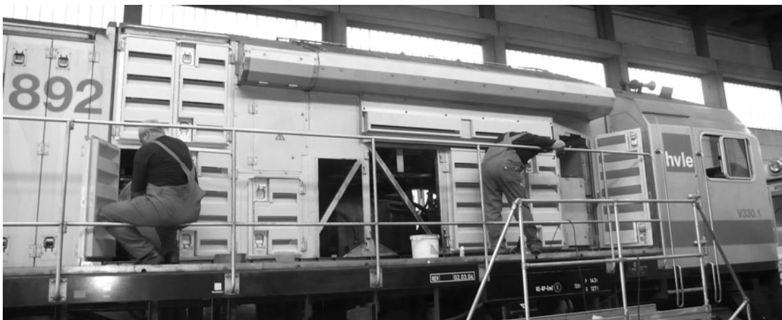
Abbildung 23: Anbau der Absorberjalousien
