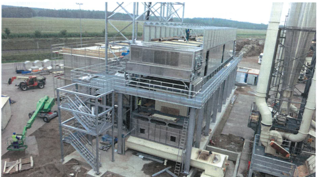
Abbildung 2-6: Montage OSB-Vortrockner im September 2015
