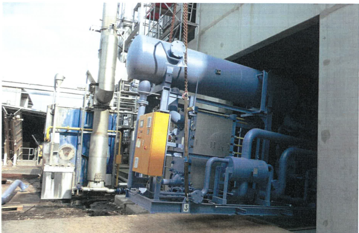
Abbildung 2-4: Montage der Wärmepumpe 1 im August 2015
