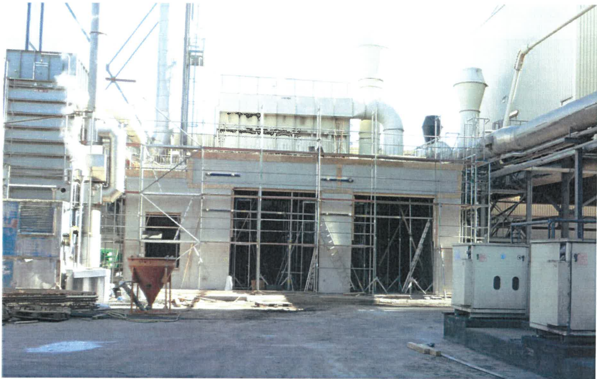
Abbildung 2-3: Bau Wärmepumpengebäude im Juli 2015
