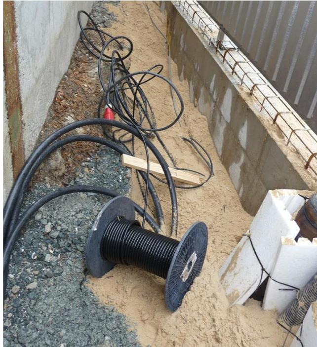
Abbildung 12: Verlegung des elektrischen Anschlusses für die neuen Trockenkammern (Aufnahmedatum 10.01.2013)
