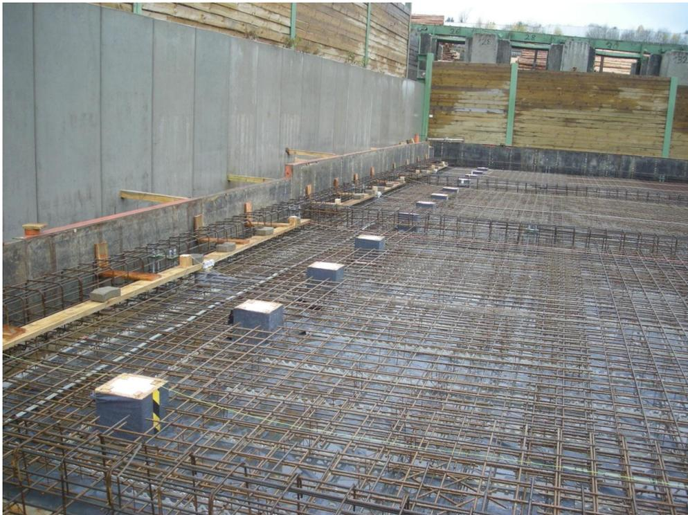
Abbildung 10: Bewehrung der Bodenplatte vor dem Gießen der Bodenplatte (Aufnahmedatum 07.11.2012)
