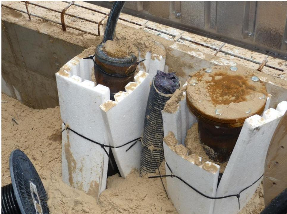
Abbildung 13: Verlegung der Heizwasserrohre für die neuen Trockenkammern (Aufnahmedatum 10.01.2013)
