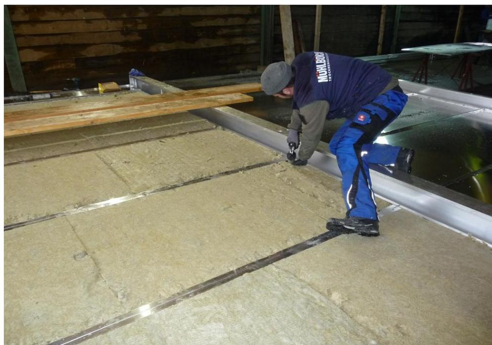
Abbildung 19: Verkleben der Wärmedämmung mit der Seitenwand (Aufnahmedatum 10.01.2013)
