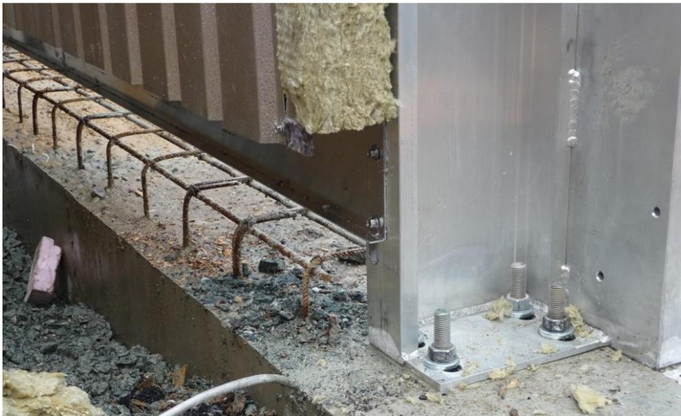
Abbildung 21: Aufständering der Wände zum Schutz vor mechanischen Beschädigungen beim Befüllen und Entleeren der Trockenkammern (Aufnahmedatum 10.01.2013)
