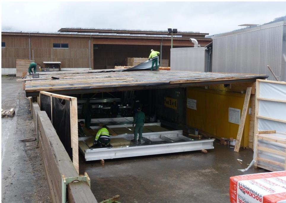
Abbildung 17: Provisorische Montagehalle zum Zusammenbau der Wände der neuen Trockenkammern (Aufnahmedatum 10.01.2013)
