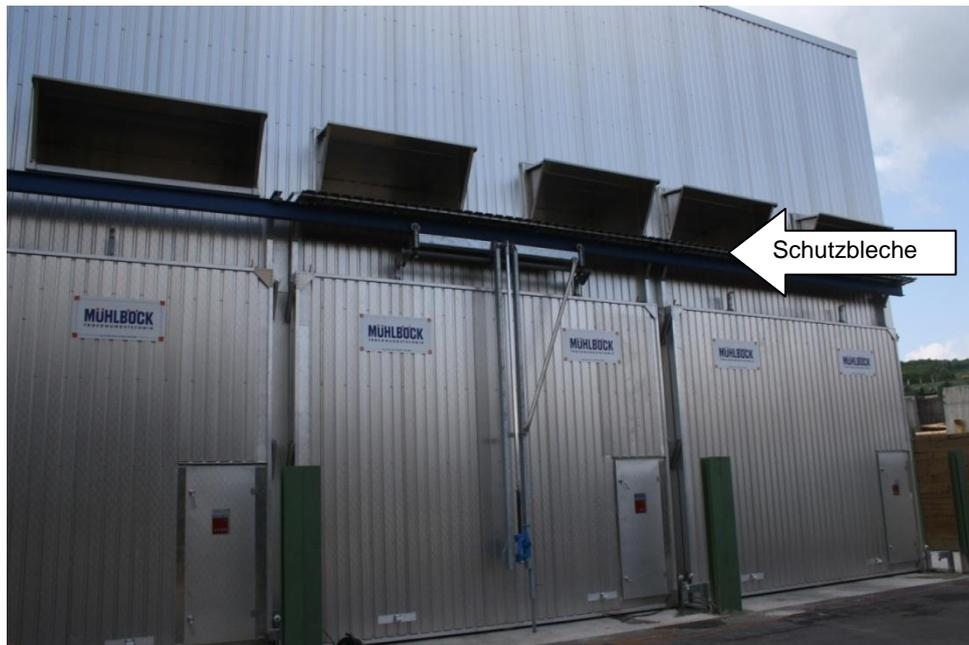
Abbildung 26: Schutzbleche mit Vordach an den Trockenkammern 5-9 (Aufnahmedatum 04.07.2013)
