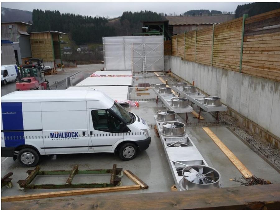
Abbildung 11: Übersicht über die Bodenplatte für die neu zu errichtenden Trockenkammern, im Hintergrund die bereits montierte linke Außenwand (Aufnahmedatum 10.01.2013)
