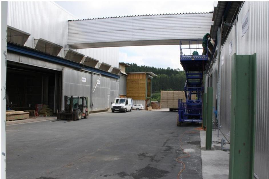
Abbildung 31: Luftbrücke, die die Trockenkammern miteinander verbindet (Aufnahmedatum 04.07.2013)
