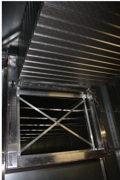
Abbildung 30: Offener Teil eines Wärmekanal (Aufnahmedatum 04.07.2013)
