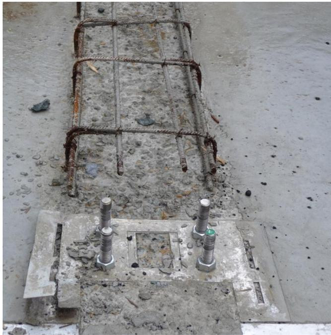
Abbildung 20: Befestigungspunkte zur Aufständering der Wände zum Schutz vor mechanischen Beschädigungen beim Befüllen und Entleeren der Trockenkammern (Aufnahmedatum 10.01.2013)
