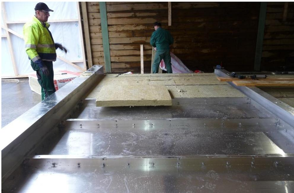
Abbildung 18: Montage der Seitenwände der neuen Trockenkammern mit Personal der Fa. Mühlböck (blaue Overalls) wie auch eigenem Personal (grüne Overalls) beim Einbringen der Wärmedämmung (Aufnahmedatum 10.01.2013)
