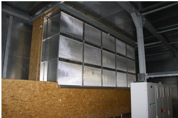
Abbildung 29: Inner Bereich der Trockenkammer mit Abbildung eines Wärmetauschers (Aufnahmedatum 04.07.2013)
