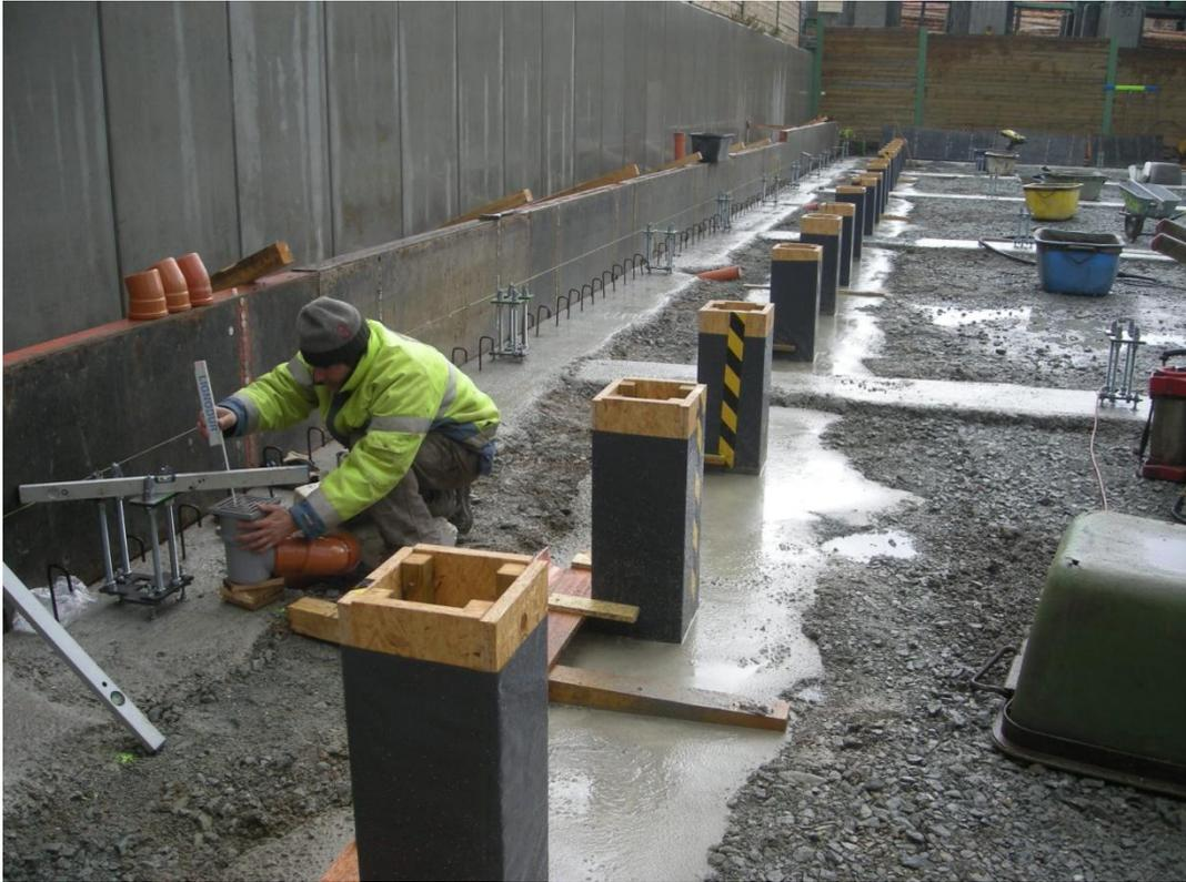
Abbildung 8: Herstellung der Fundamente der neuen Trockenkammern (Aufnahmedatum 30.10.2012)
