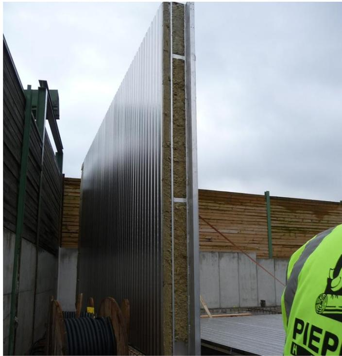
Abbildung 22: Erste montierte Seitenwand der neuen Trockenkammern (mit elektrischen Anschluss zur Energieversorgung) und Schichtaufbau (Metallverkleidung – Wärmeschutzschicht – Metallverkleidung) der Wände (Aufnahmedatum 10.01.2013)
