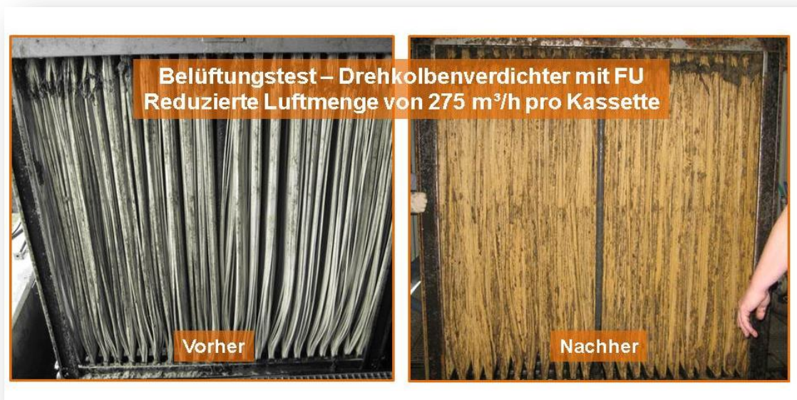
Abbildung 5: GKW Nordkanal – Belüftungstest mit dem Drehkolbenverdichter bei der reduzierten Luftmenge von 275 m 3 /h pro Kasette bei Air-cycling-Belüftung
