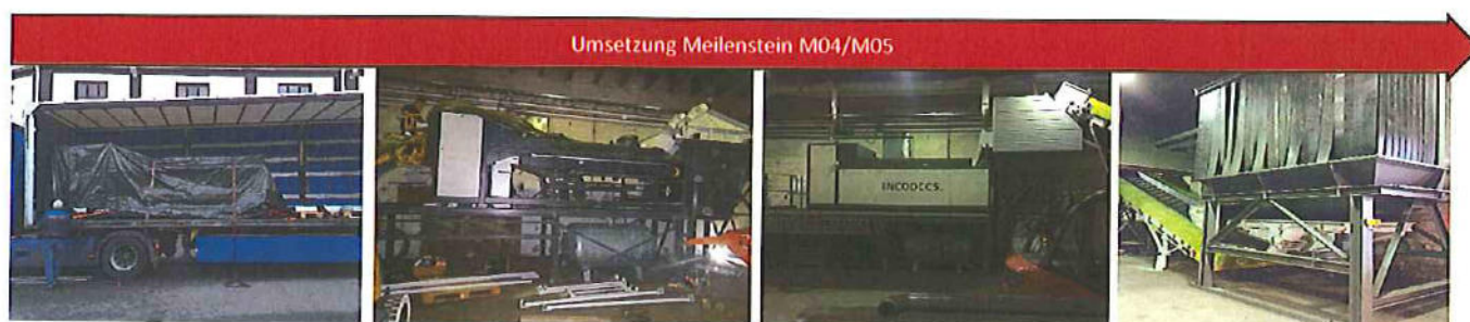
Abbildung 6: Visuelle Details des Meilensteins M04/05 Von der Anlieferung über die Montage bis zur Fertigstellung der Metallseparationsanlage am Standort der Eisenwerk Erla GmbH in Schwarzenberg / Sachsen
