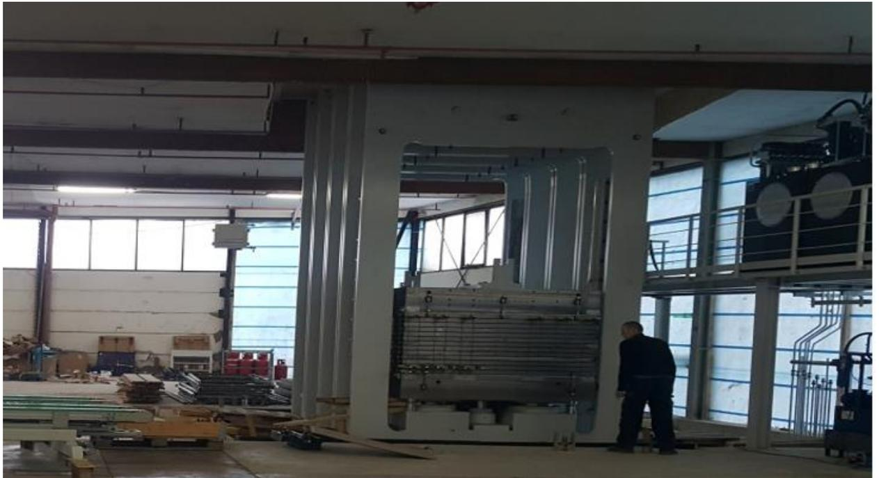
Abbildung 8: Aufstellen Pressrahmen und Einbringen der Pressetagen (Foto vom 03.01.2017)
