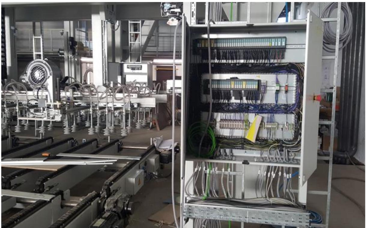
Abbildung 13: Elektrischer Schaltkasten, Verkabelung, Heißwasserzu- und -abläufe (Foto vom 14.02.2017)
