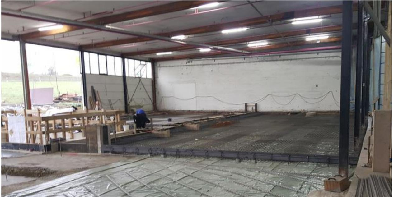
Abbildung 6: Einbringung der neuen Hallensohle (Foto vom 15.11.2016)
