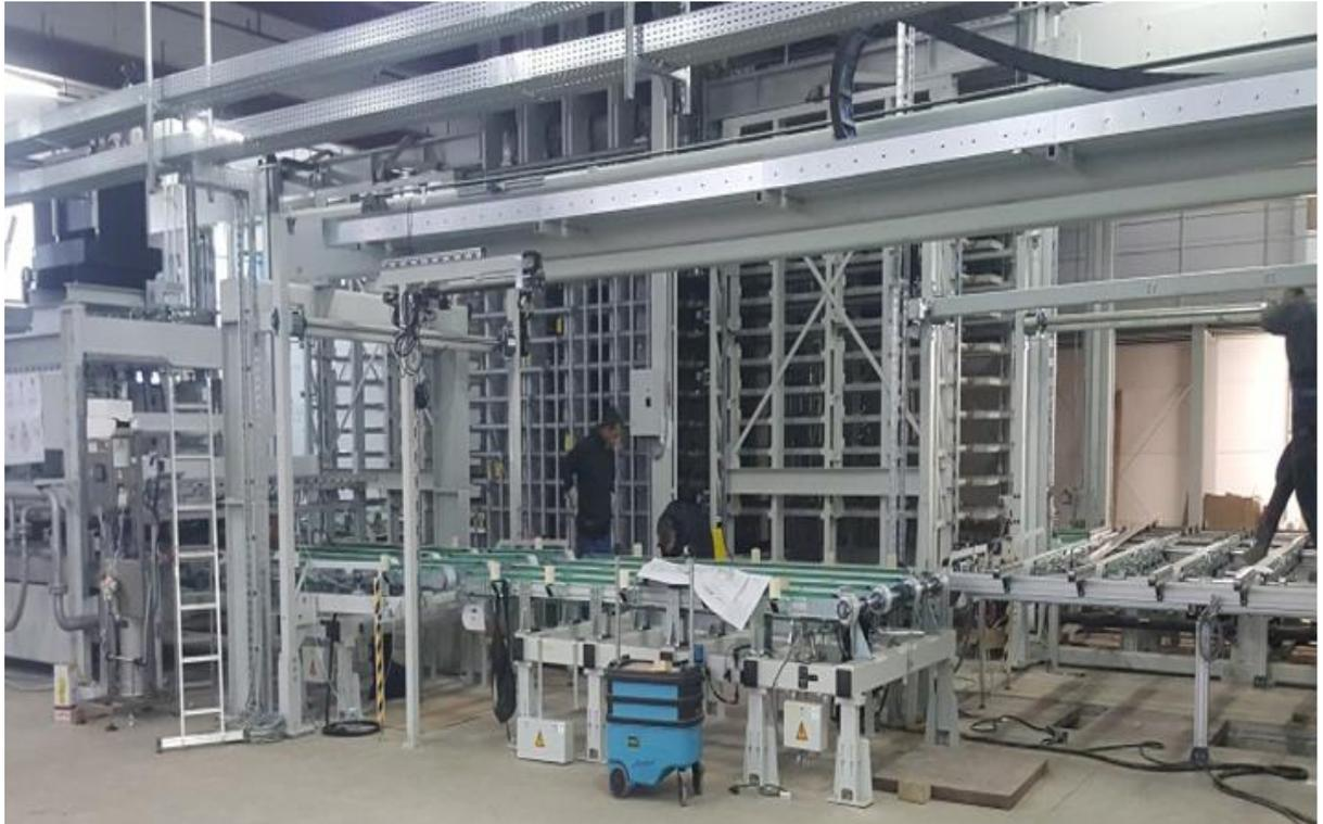
Abbildung 12: Montage der Transportgestelle (Foto vom 06.02.2017)
