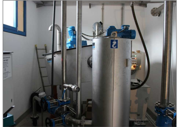
Abbildung 4: Maschinelle Schlammeindickung
