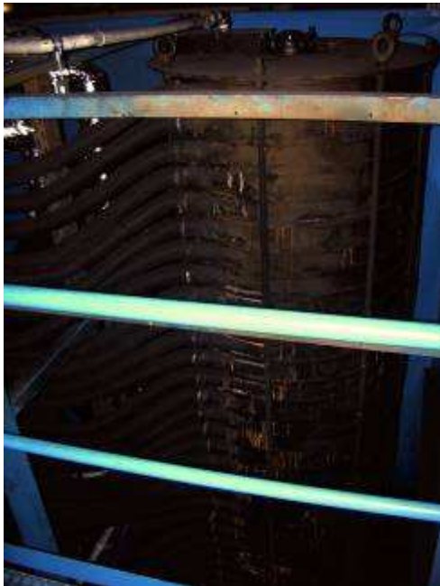
Heizungsanlage für den Trockner zur Aufwärmung der Trockenluft. Die Wärme liefern die Kondensatoren.
