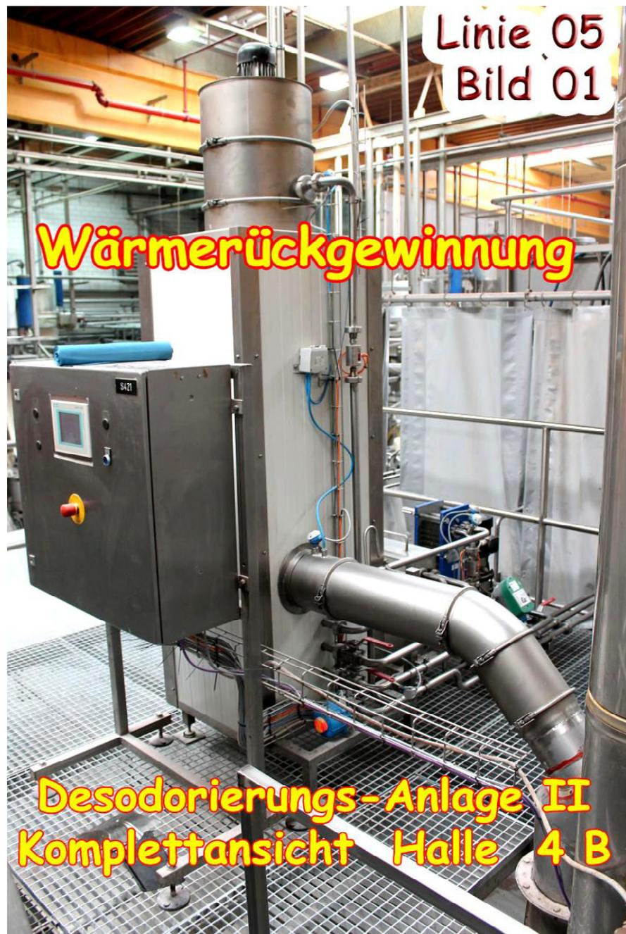
Abbildung 6: Gesamtansicht Wärmerückgewinnung Ofen Anlage 5, Aufnahme aus 2013
