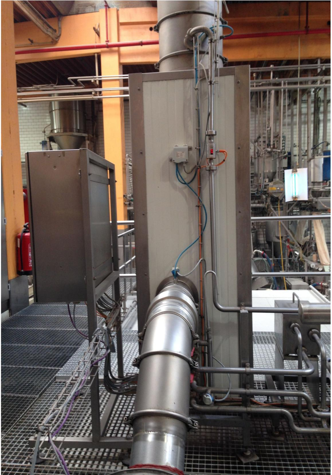
Abbildung 10: Wärmerückgewinnung an Desodorierungs-Anlage II (Linie 5), Aufnahme aus März 2014
