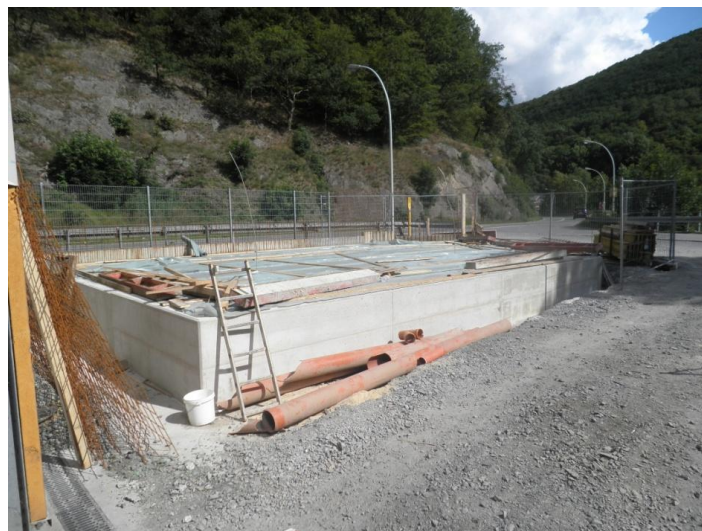
Abbildung 10: Fundament für H_2/N_2 Schutzgasversorgung außerhalb der Halle
