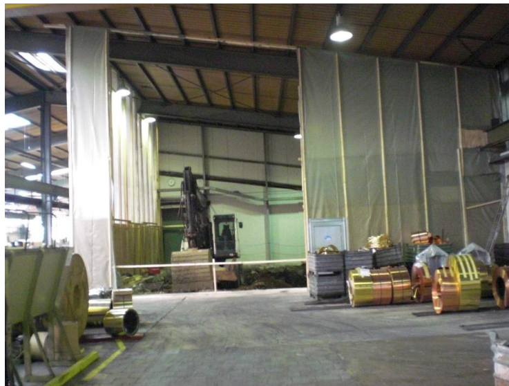
Abbildung 9: Umbauarbeiten in der Halle
