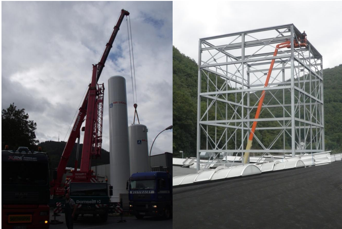
Abbildung 11: Aufstellung Wasserstoff- und Stickstoffbehälter Abbildung 12: Hallenkonstruktion für die neue Glühanlage
