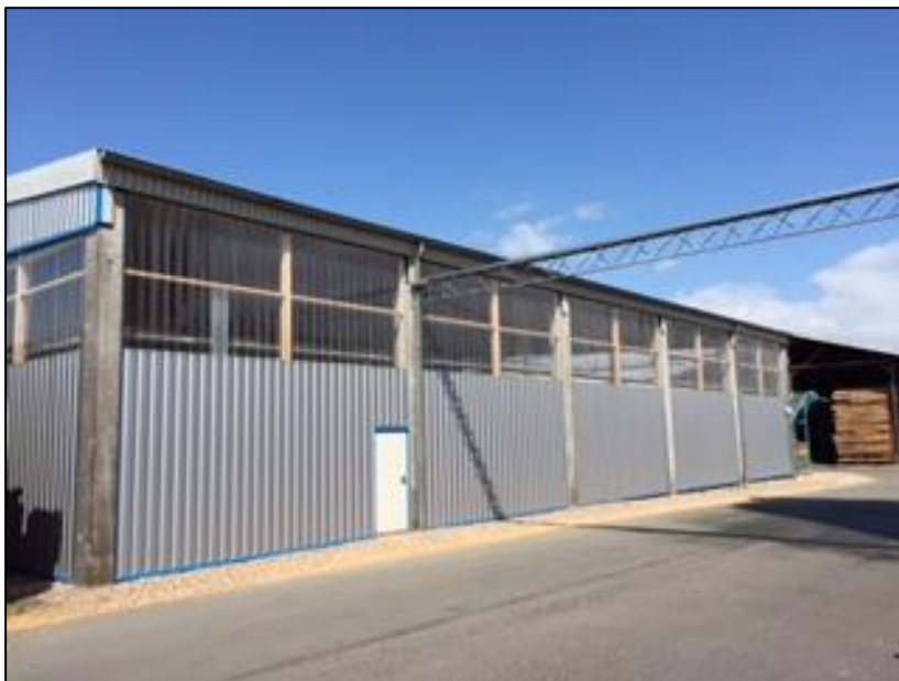
Abb. 25: Außenansicht Produktionshalle des Vorhabens
