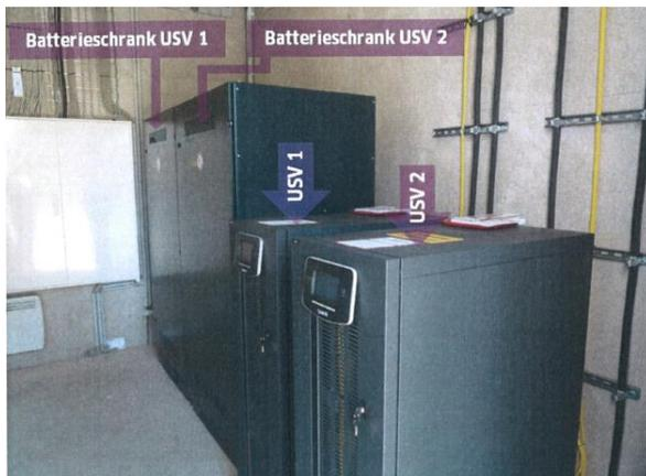
Abbildung 11: Hilfsspannungsversorgung / USV
