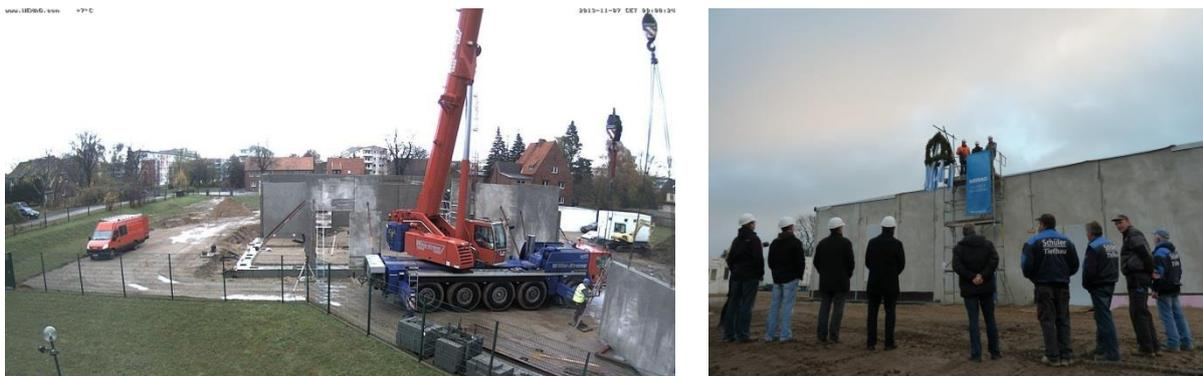
**Abbildung 5: Montage Fertigteile, Decke und Fassade sowie Außenanlagen - Rohbau<sup>5</sup>**
