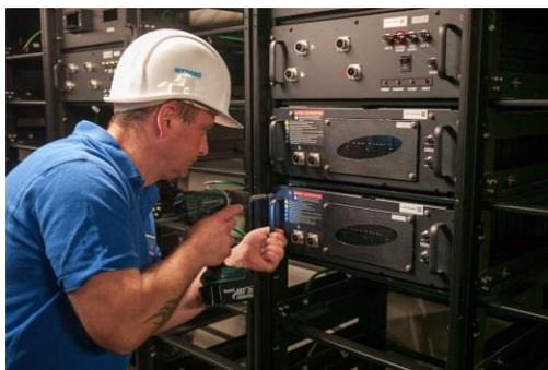
**Abbildung 7: Auf- und Einbau der Batterieeinschübe**
