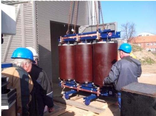
**Abbildung 9: Einbringen der Transformatoren**
