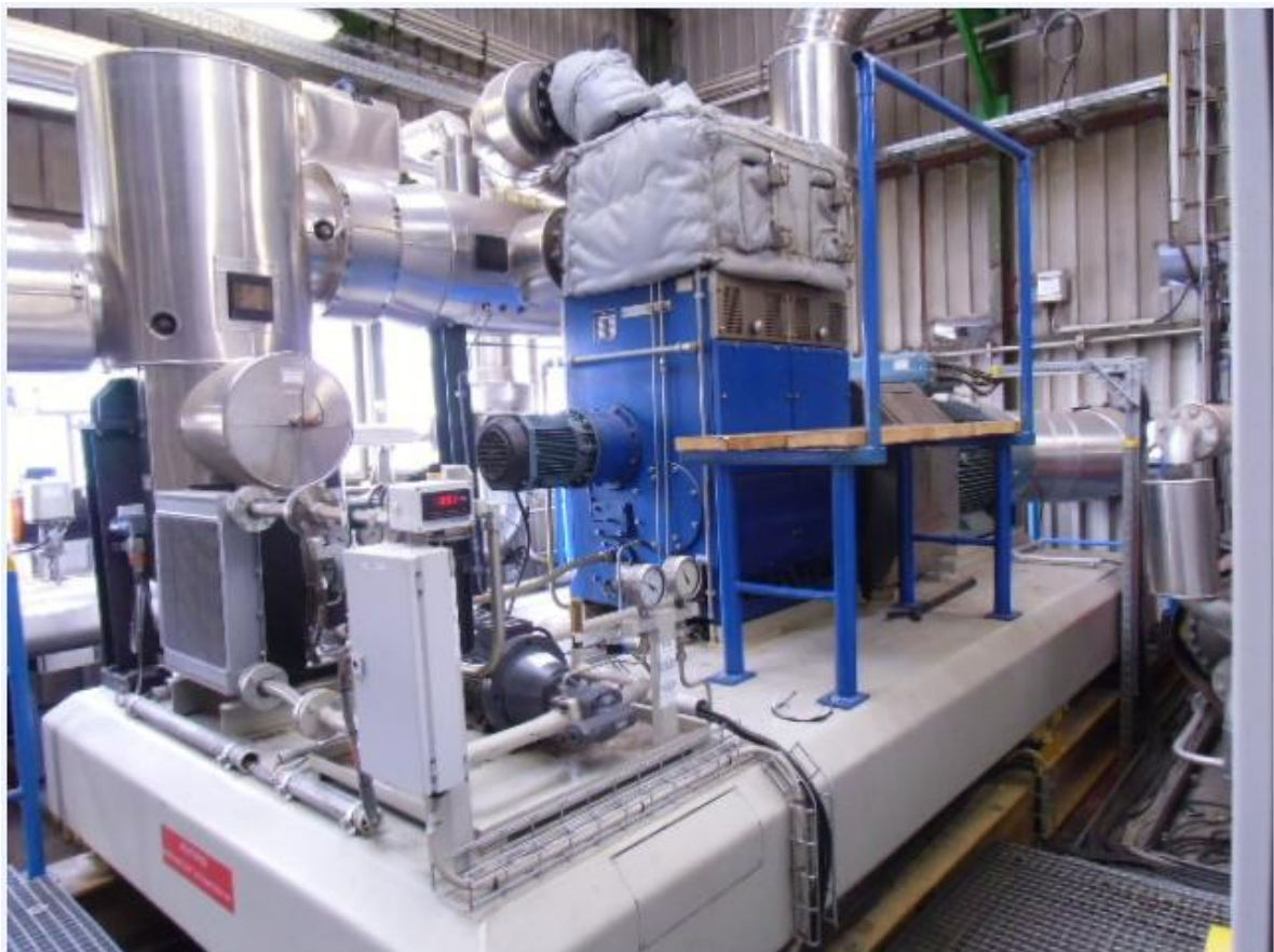
Abb. 6: Aufstellung des Dampfmotors im vorhandenen Gebäude [Quelle: Akzo Nobel Functional Chemicals GmbH]
