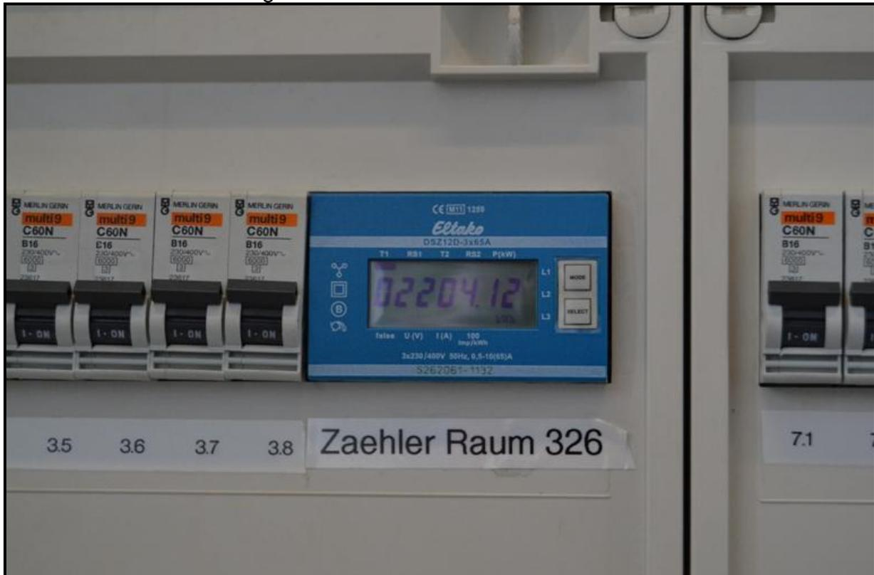
Abbildung 9: Installierter Unterzähler für den Raum 326 im Schaltschrank der Unterverteilung
