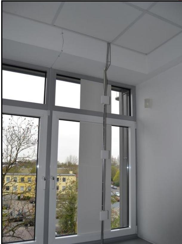
**Abbildung 4: Messampel mit drei Fühlern für Raumtemperatur, CO<sub>2</sub>-Gehalt und relative Luftfeuchtigkeit**
