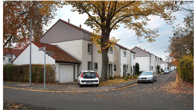
Die neuen LED-Module im Einsatz | Quelle: Stadt Düsseldorf
