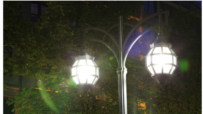
Neue energieeffiziente Lampen in den alten Leuchtsystemen Quelle: Stadt Düsseldorf
