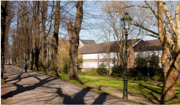
Die alte Beleuchtungsanlage der Burgallee mit Quecksilberdampf-Hochdrucklampen | Quelle: Stadt Düsseldorf
