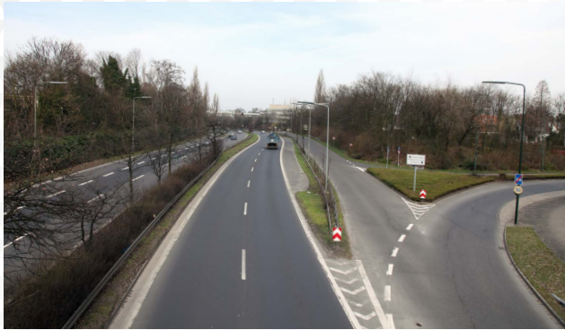
Die Beleuchtungsanlage der Danziger Straße stammte noch aus den 1960er Jahren | Quelle: Stadt Düsseldorf
