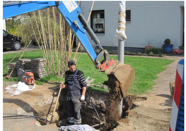
Umrüstung der Beleuchtungsanlage in Düsseldorf | Quelle: Stadt Düsseldorf
