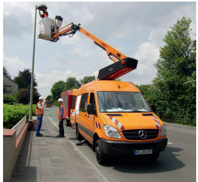
Installation der neuen Leuchten | Quelle: Stadt Geseke
