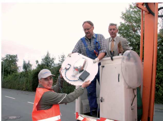
Installation der neuen Leuchtmittel | Quelle: Stadt Geseke
