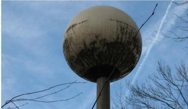
Stark verschmutzte alte Kugelleuchten mit Quecksilberdampf lampen
