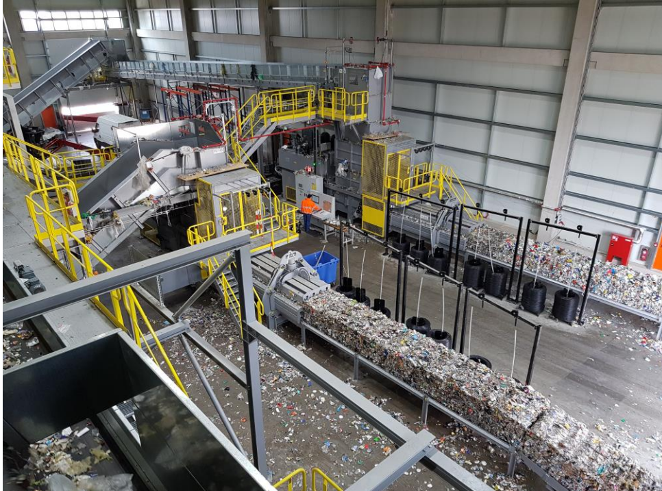
Abbildung 14: Verpressen der getrennten Materialien mittels zweier Ballenpressen
