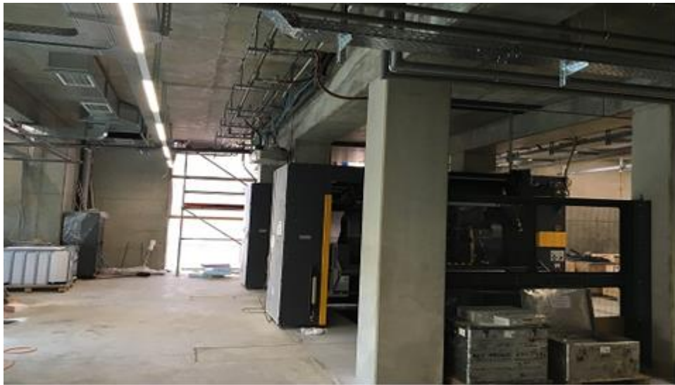
Abbildung 23: Eingebraachte Rollensterne unter dem Betontisch, Februar 2018
