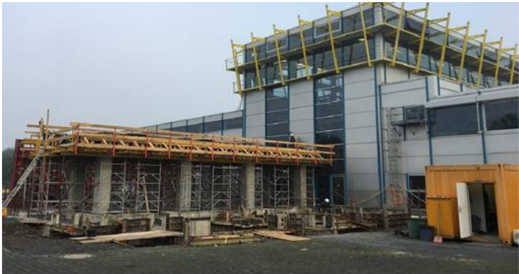
Abbildung 20: Erstellung der Verschalung für den Betontisch, September 2017
