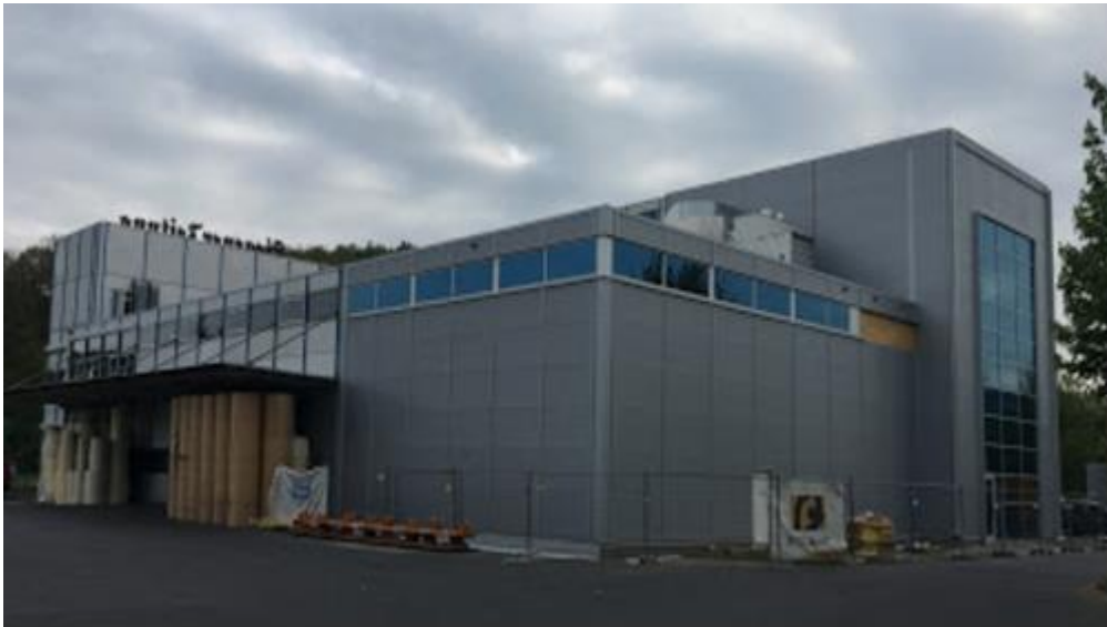
Abbildung 24: Verschlussener Gebäudeanbau, März 2018
