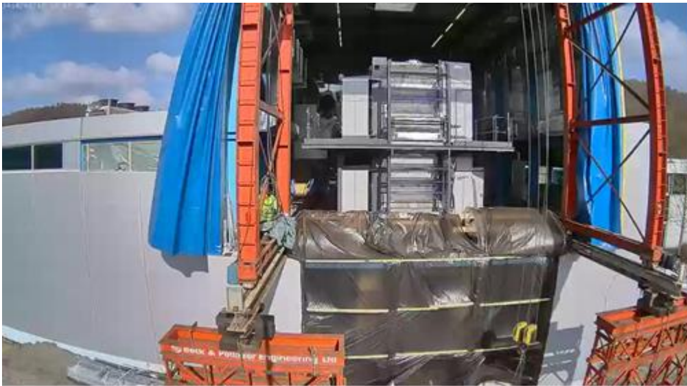
Abbildung 22: Einbringung der Maschinenteile mittels Portalkran, Februar 2018
