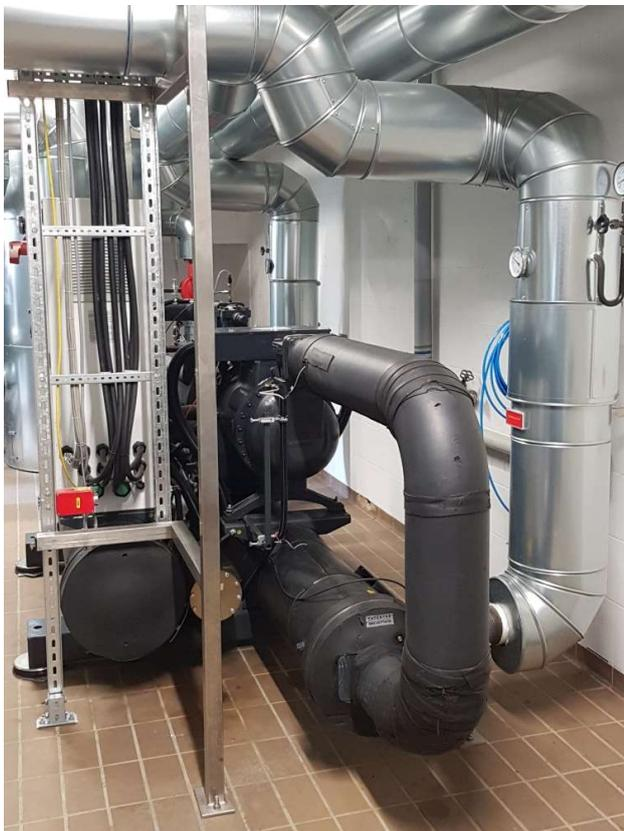
Abbildung 15: Einbindung HTWP
