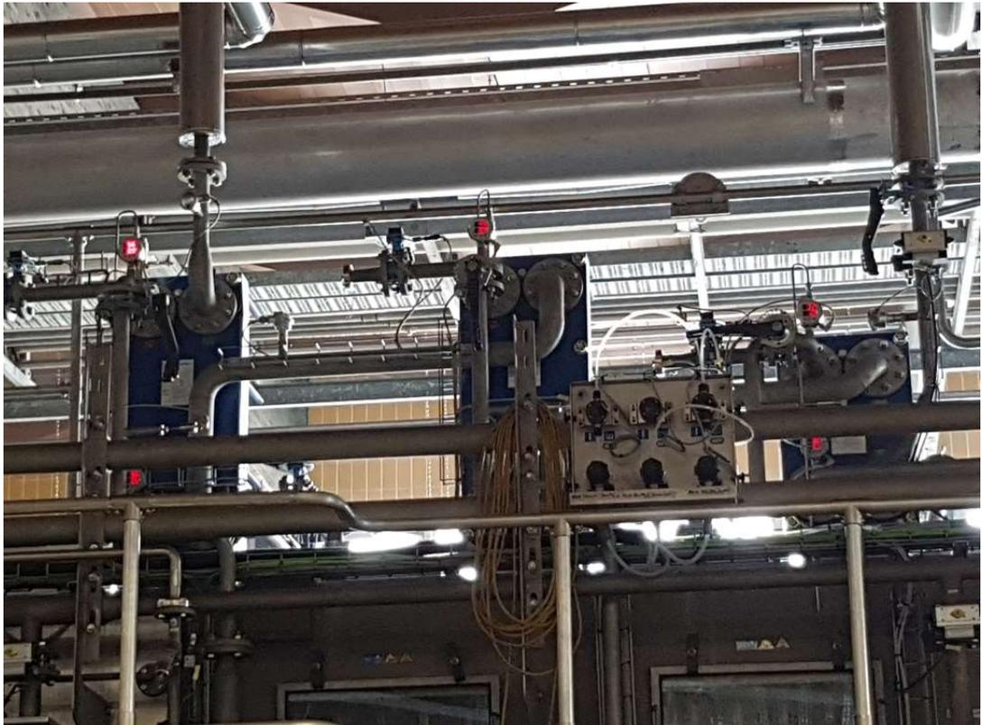
Abbildung 3: Wärmetauscher zur Kühlung der Nachbehandlungszonen
