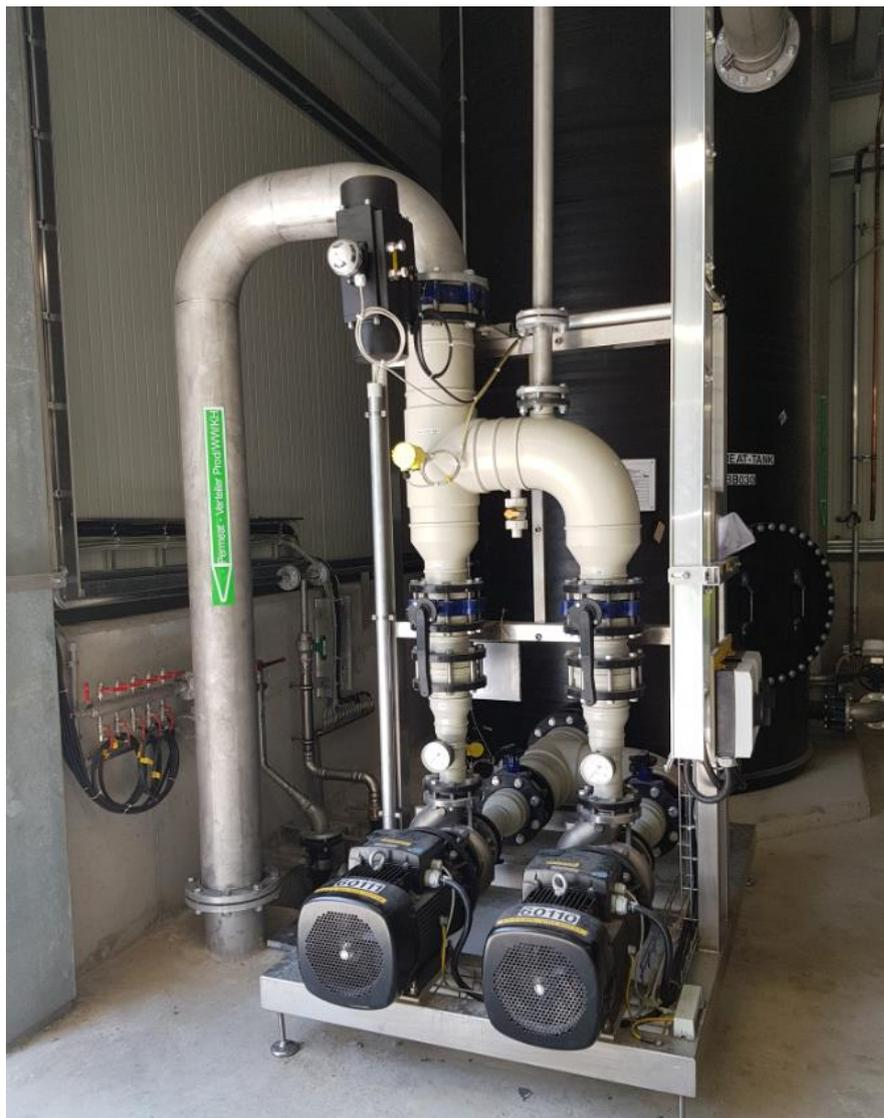
Abbildung 29 Bild Permeat- Tank und Pumpstation
