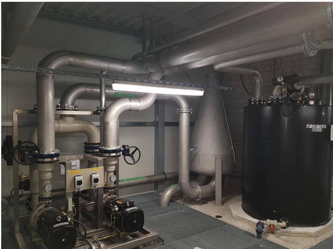
Abbildung 28 Bild Pumpstation, UF-CIP Tank und Bicone
