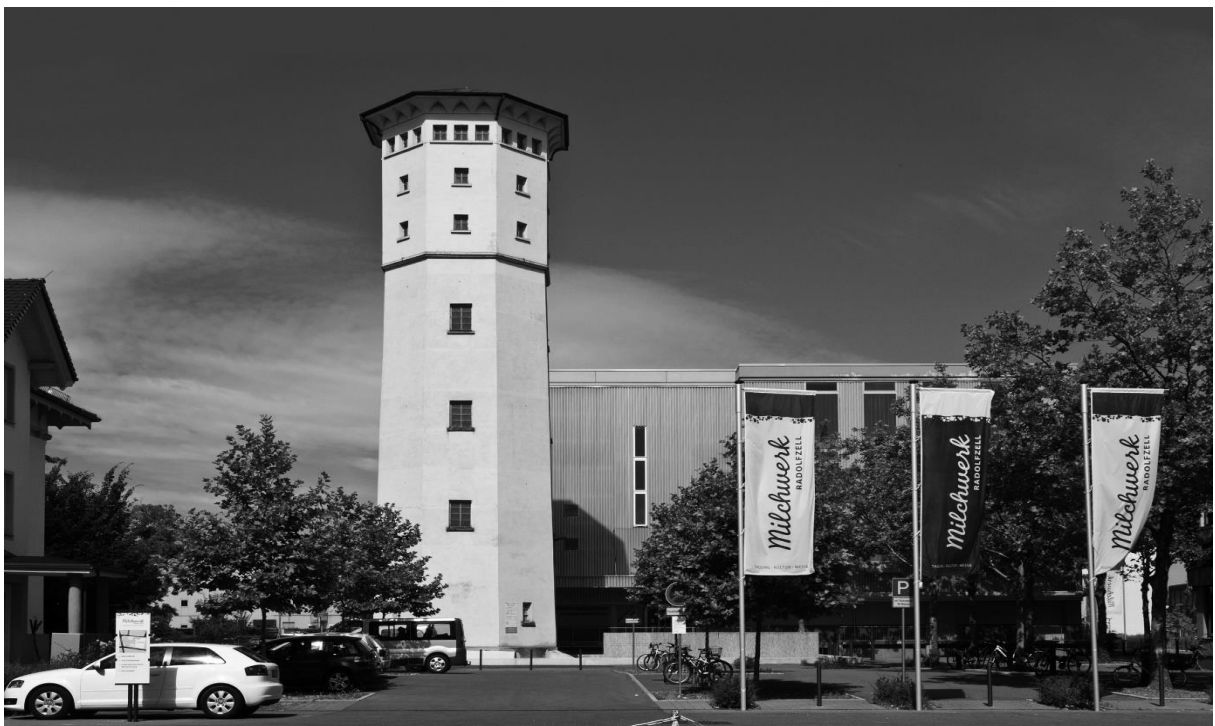
Abbildung 1 Alter Wasserturm Radolfzell 1956 bis 2008
