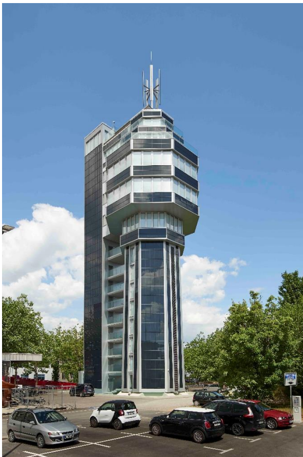
Abbildung 2 Ansichten des aquaTurms nach der Sanierung 2017
