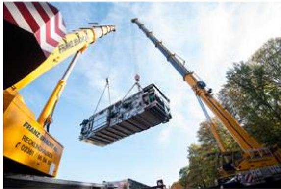
Abbildung 10: Flaschenwaschmaschine am Haken von zwei Autokränen
