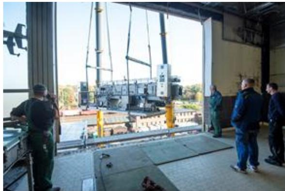
Abbildung 8: Einbringung Kastenwascher
