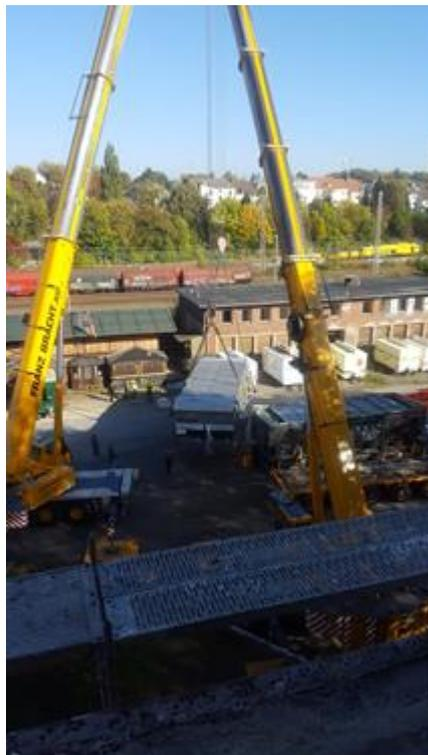
Abbildung 7: Ausbringung Altmaschine mit zwei Autokränen
