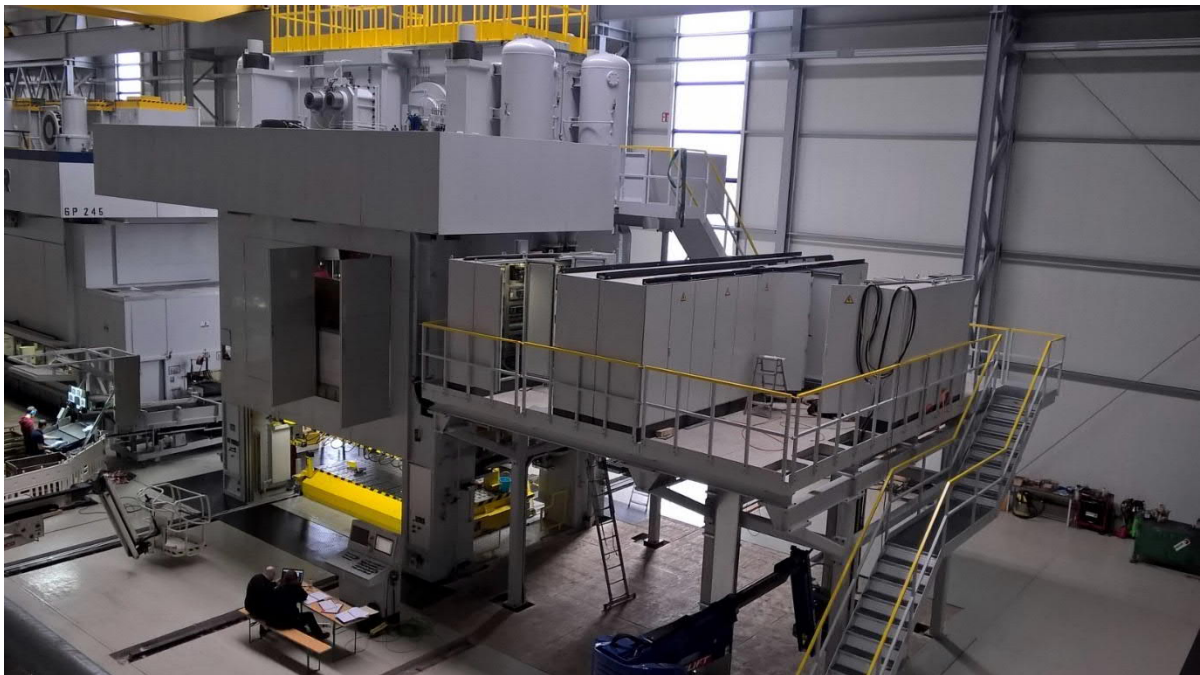
Abbildung 5: Inbetriebnahme der Anlage am Standort Oelsnitz (2/3)
