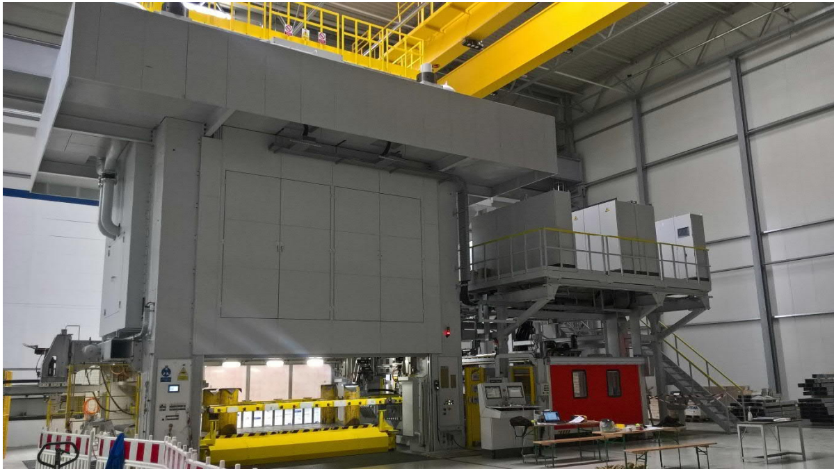
Abbildung 6: Inbetriebnahme der Anlage am Standort Oelsnitz (3/3)
