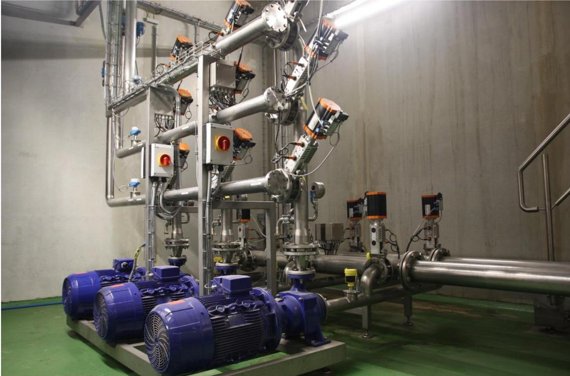
Abbildung 4: Abwasserhebeanlage im Einleitbauwerk
