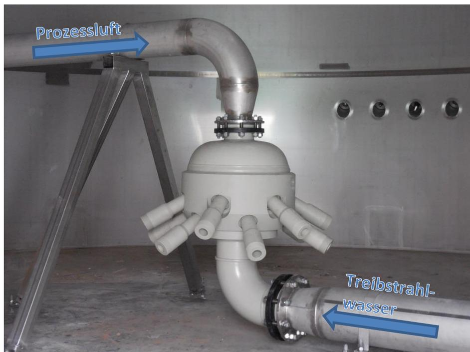
**Abbildung 5: Ejektor zur Belüftung der Belebungsbecken**
