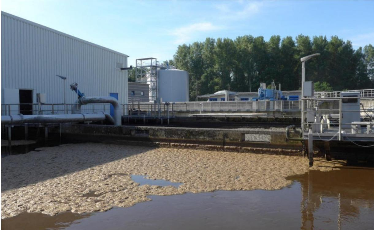
**Abbildung 9: Belebungsbecken (Denitrifikation) und Membranfilterhalle**
