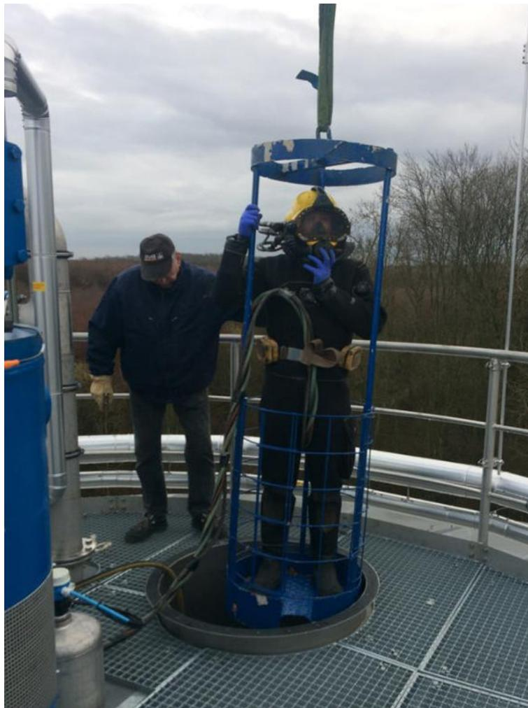
**Abbildung 16: Tauchereinsatz zur Beseitigung einer Betriebsstörung am Faulbehälter**
