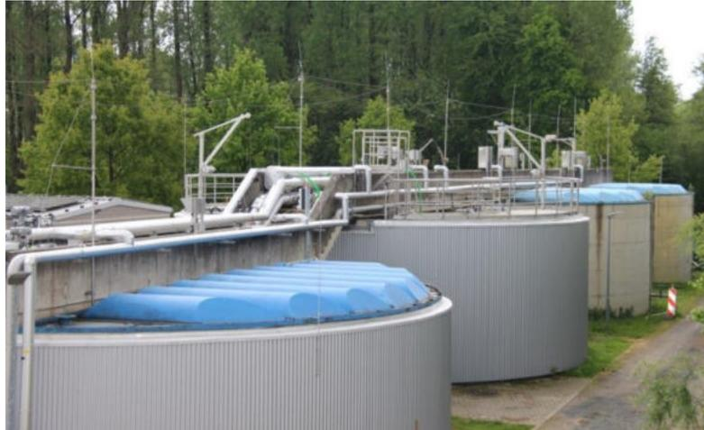
**Abbildung 13:** Trübwasserspeicher (vorne) und Reaktor für die Deammonifikation (Mitte) mit außenliegender Wärmeisolierung, im Hintergrund die Schlammspeicher für Primär- und Faulschlamm
