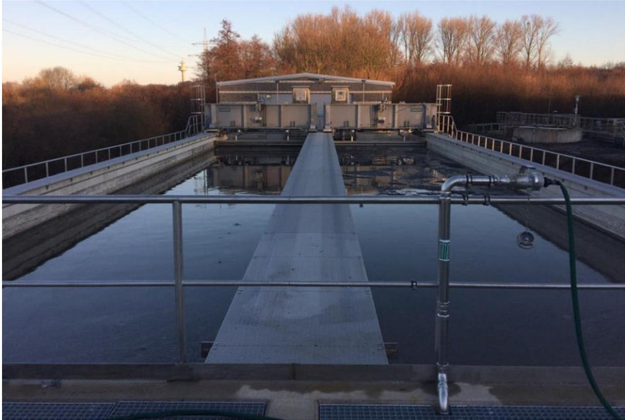
**Abbildung 7: Vorklärbecken mit zwei Kammern und Längsräumer**
