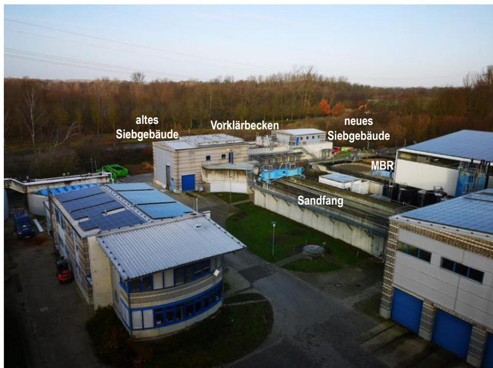
Abbildung 6: Blick auf die neue mechanische Abwasserreinigungsstufe
