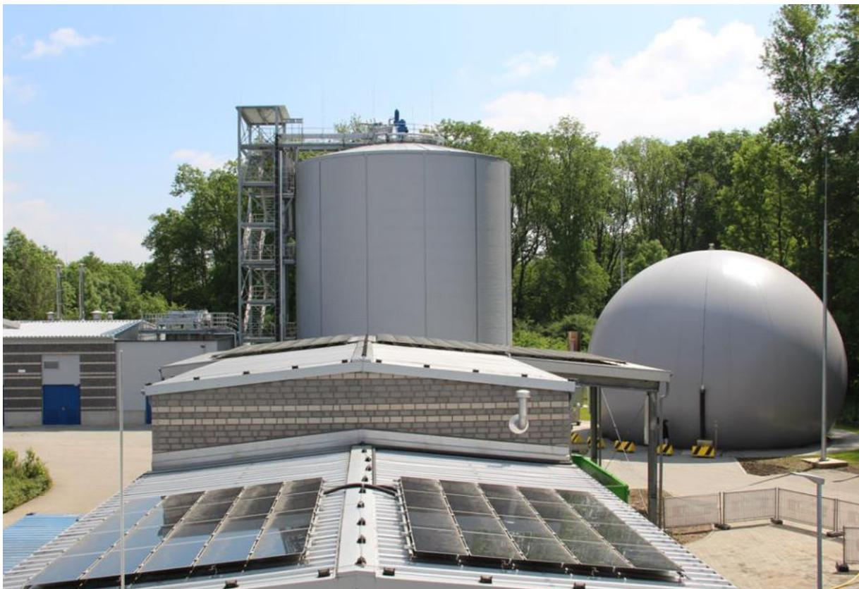
**Abbildung 10: Im Hintergrund Maschinengebäude, Faulbehälter mit Treppenturm und Gasbehälter (v.l.n.r), im Vordergrund das Dach des Schlammwässerungsgebäudes mit Fotovoltaikanlage**
