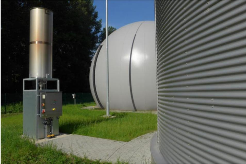
**Abbildung 12: Gasfackel und Gasbehälter**
