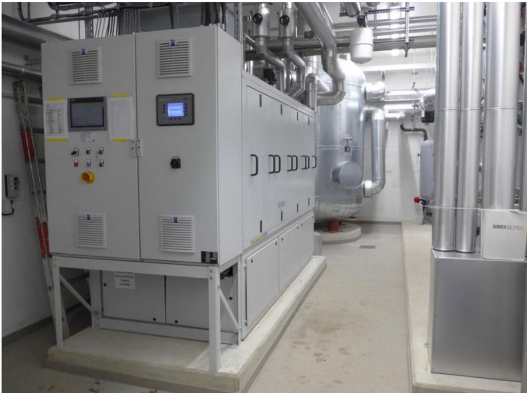
**Abbildung 11: BHKW im Maschinengebäude, mit Wärmepuffer und Heizverteiler**
