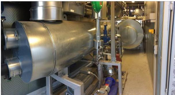
**Abb. 10:** Anlagentechnik ASCENTEC-Container (Wärmeübertragung von Thermalöl auf Ethanol)
