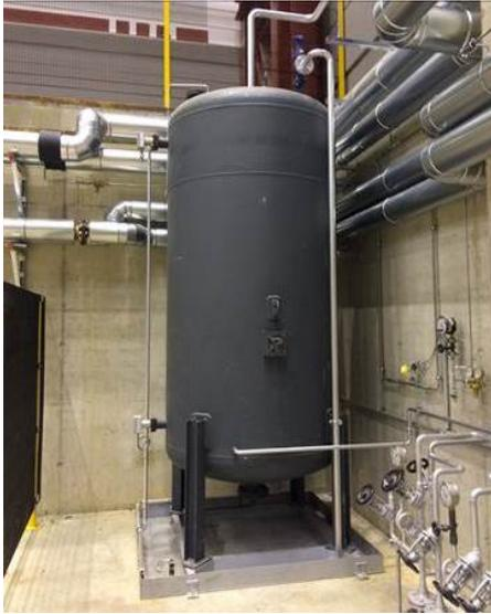
**Abb. 7:** Einbindung Thermalölsammel-tank
