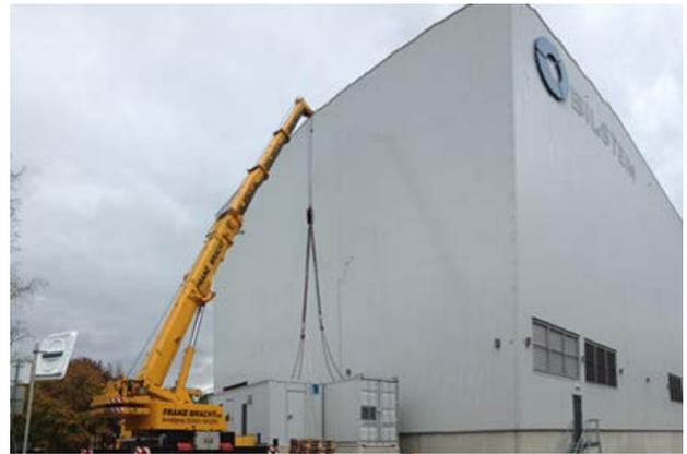
**Abb. 9:** Aufstellen, Montage und Einbindung des DeVeTec-Containers und des ASCENTEC-Containers und deren Verbindung
