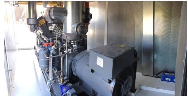
**Abb. 11:** Anlagentechnik DeVeTec-Container (ORC-Kolbenmotor und Generator zur Entspannung des Ethanoldampfes)
