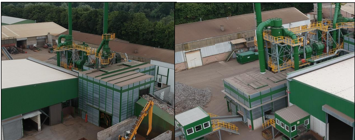
Abbildung 13: Schallschutzeinhausung an Mühle und Sichter
