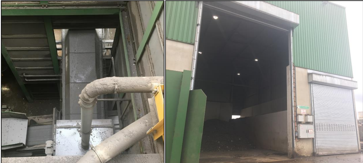
Abbildung 12: Emissionsschutz durch geschlossene Übergabestellen mit Absaugung, Förderbandabdeckungen und Verladehalle mit Rolltoren
