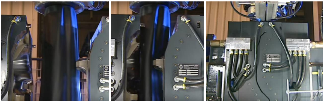
Abbildung 2: Schließvorgang und Formgebung mittels hydraulischer Presse
