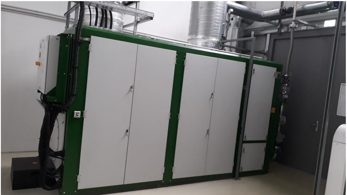
Abbildung 17 - BHKW, Foto Gelinova
