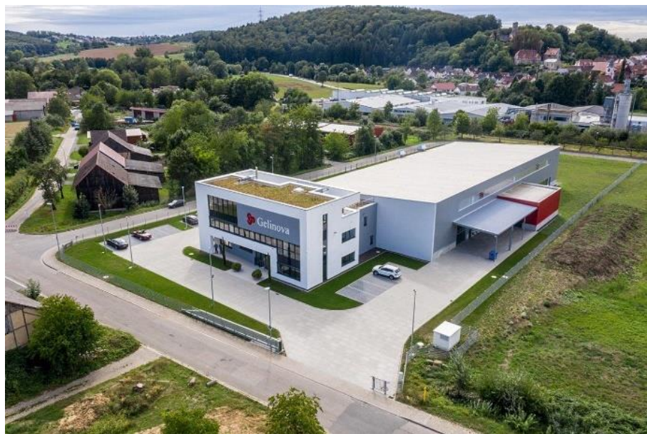
Abbildung 7 - Gebäude der Gelinova GmbH in Neidenstein, Foto Gelinova
