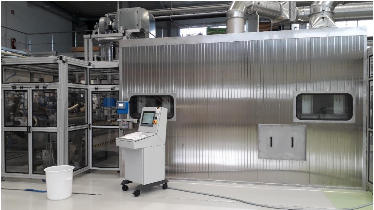
Abbildung 12 - Trocknungsanlage Gelierzzone, Foto Gelinova
